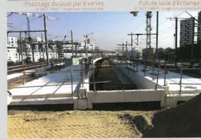
Réalisation du quai central
