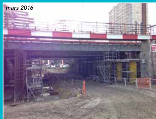
Le pont-rail depuis la rue de Crimée avant le percement de la nouvelle travée
