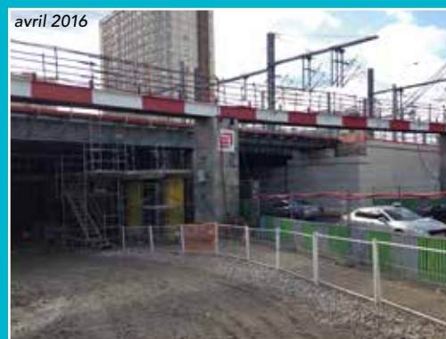
La nouvelle travée, la pile centrale et la culée côté Ouest
