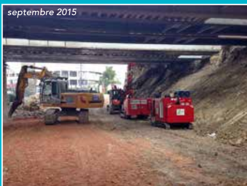
Le percement de la nouvelle travée
