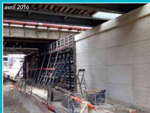
La réalisation de la culée côté Est
