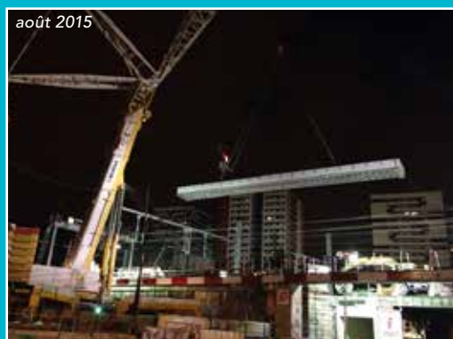
La pose des tabliers auxiliaires au-dessus de la future travée
