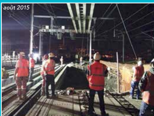
La pose des tabliers auxiliaires au-dessus de la future travée
