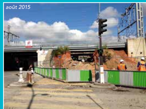
La pose des tabliers auxiliaires au-dessus de la future travée
