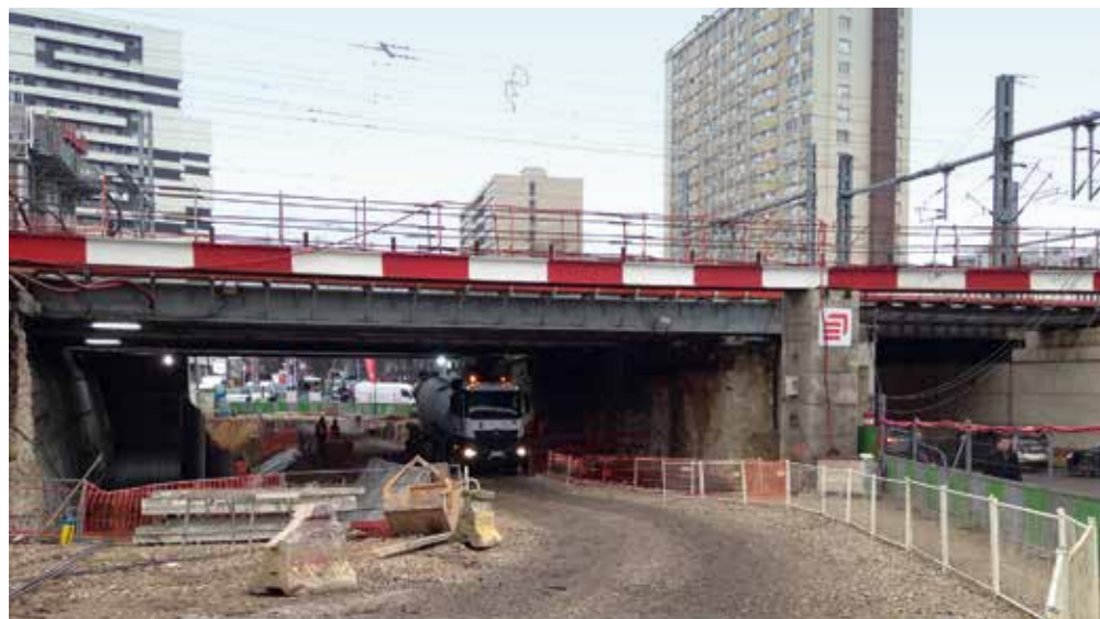
La nouvelle travée du pont-rail de la rue d'Aubervilliers (janvier 2016)
